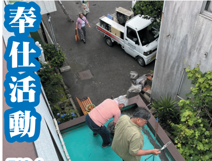
5/24 屋上清掃と軽トラ上のエアコン
