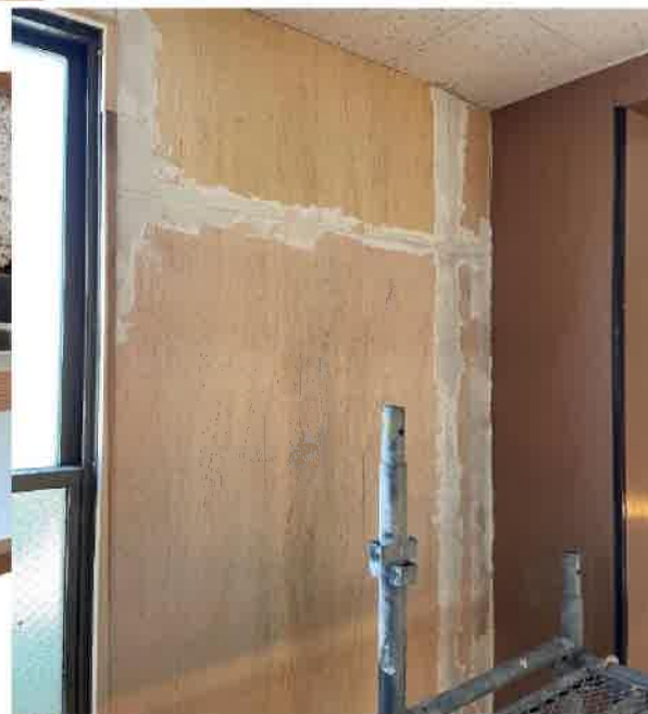
2021年9月19日・20日の壁修復工事の様
