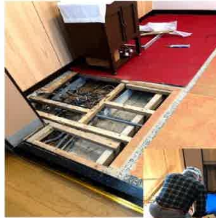
玉里教会祭壇改修工事
